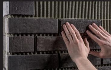
Das Setzen der Flächen-Klinkerriemchen mithilfe einer Schnur. Die Klinkerriemchen werden in das Klebbett eingedrückt.
