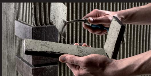
Die Eckwinkel werden im Floating-Buttering-Verfahren verarbeitet.
