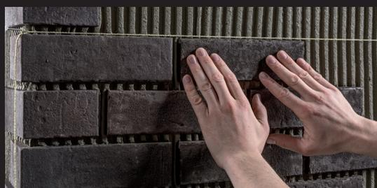
Das Setzen der Flächen-Klinkerriemchen mithilfe einer Schnur. Die Klinkerriemchen werden in das Klebett eingedrückt.
